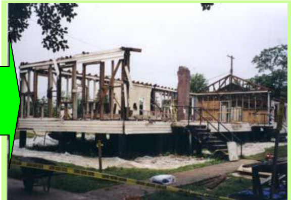
3. 拆除內部結構
