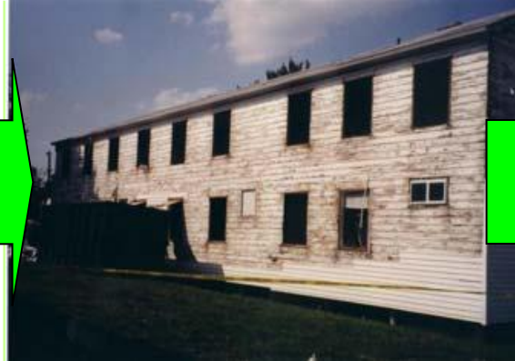
2. 拆除外部牆面
