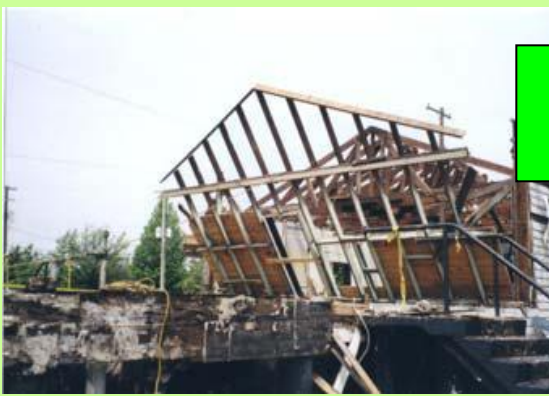
4. 拆除外部結構
