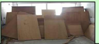
室內裝潢拆除
