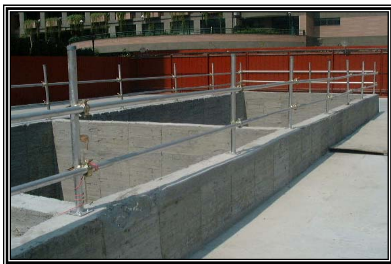
圖 4-2 棄土坑及沈澱池示意圖
