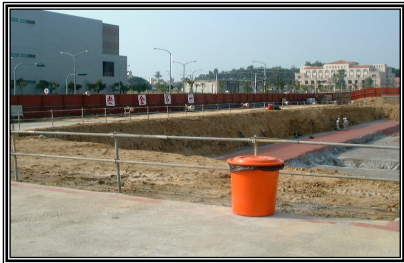
圖 4-4 斜坡明挖工法上部安全欄杆圖
