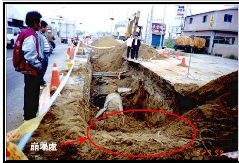
圖 4-13 管溝開挖現場危險狀況示意圖
